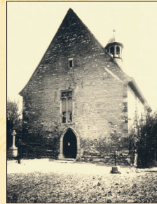
Johanneskirche Westfassade bis 1903
